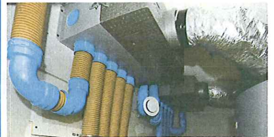
De verdeelkast van het flexibele lichtdistributiesysteem Hybalans van Burgerhout.
